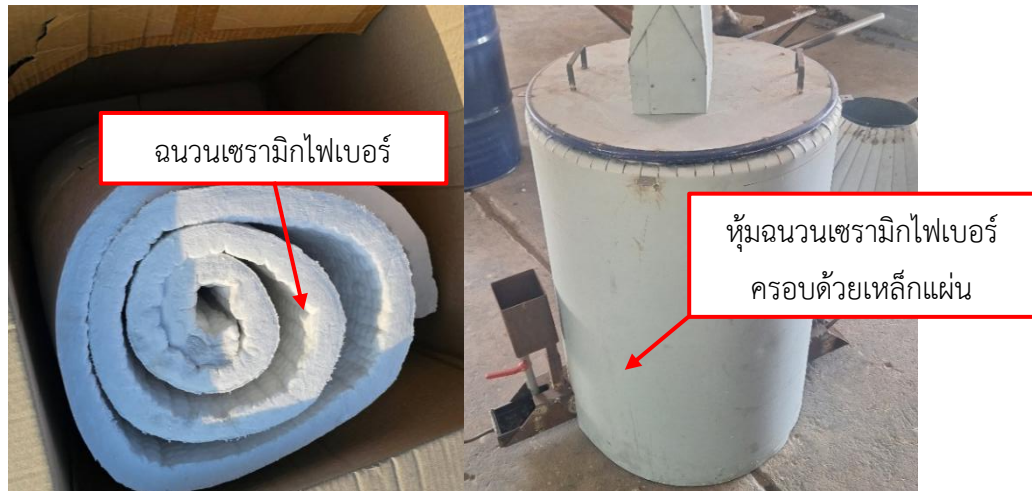
ภาพที่ 3.8 หุ้มฉนวนกันความร้อนด้วยเซรามิกไฟเบอร์
